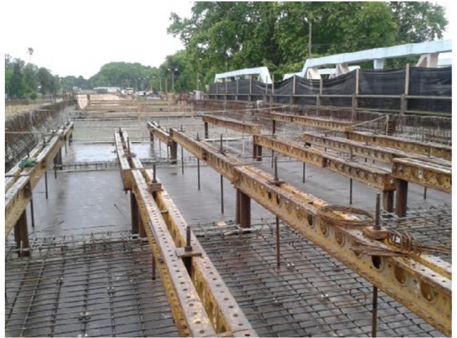
Encofrado y armadura para losa
