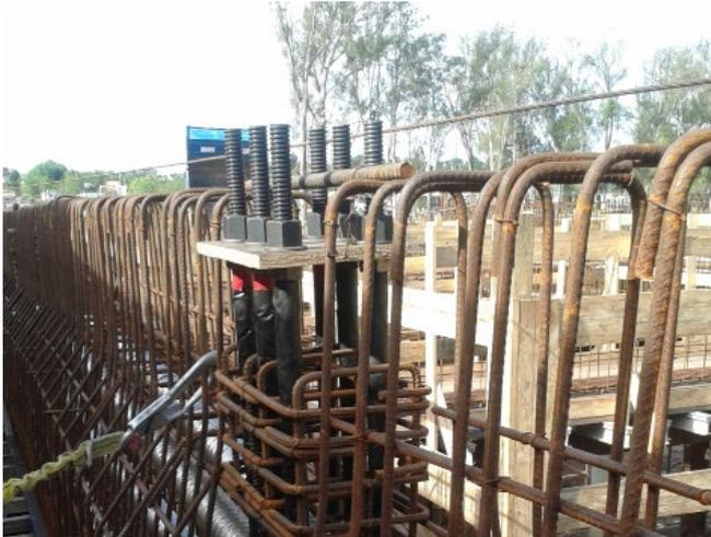
Piezas sistema de péndolas y vainas para postensado en viga longitudinal
