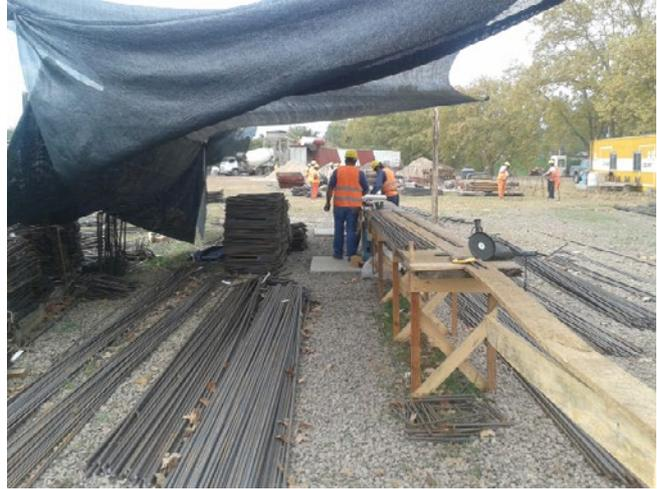
Corte y doblado de armaduras en obrador
