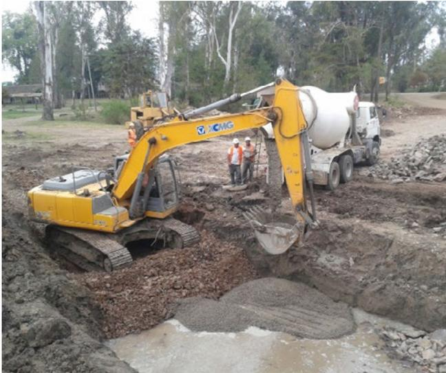
Hormigón de limpieza bajo pila central
