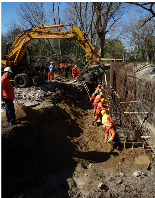
Puente sobre Cañada Casavalle
