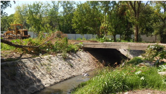
Puente sobre cañada Casavalle
