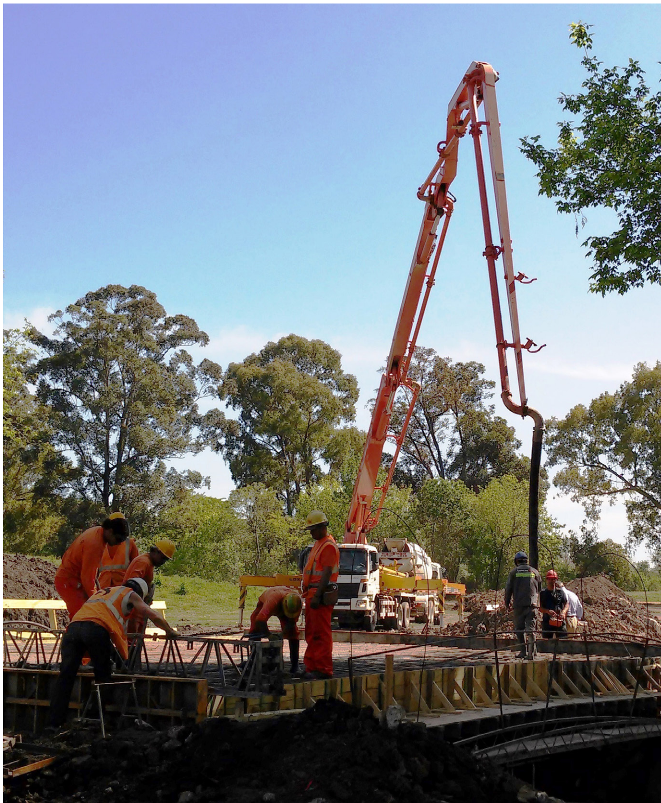
Puente sobre cañada Casavalle
