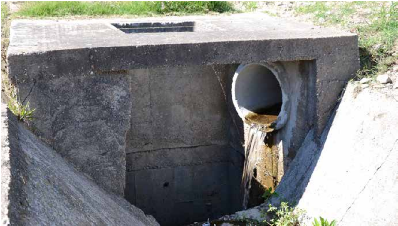
Rambla y Calle 2 (drenaje finalizado sobre Calle 1)
