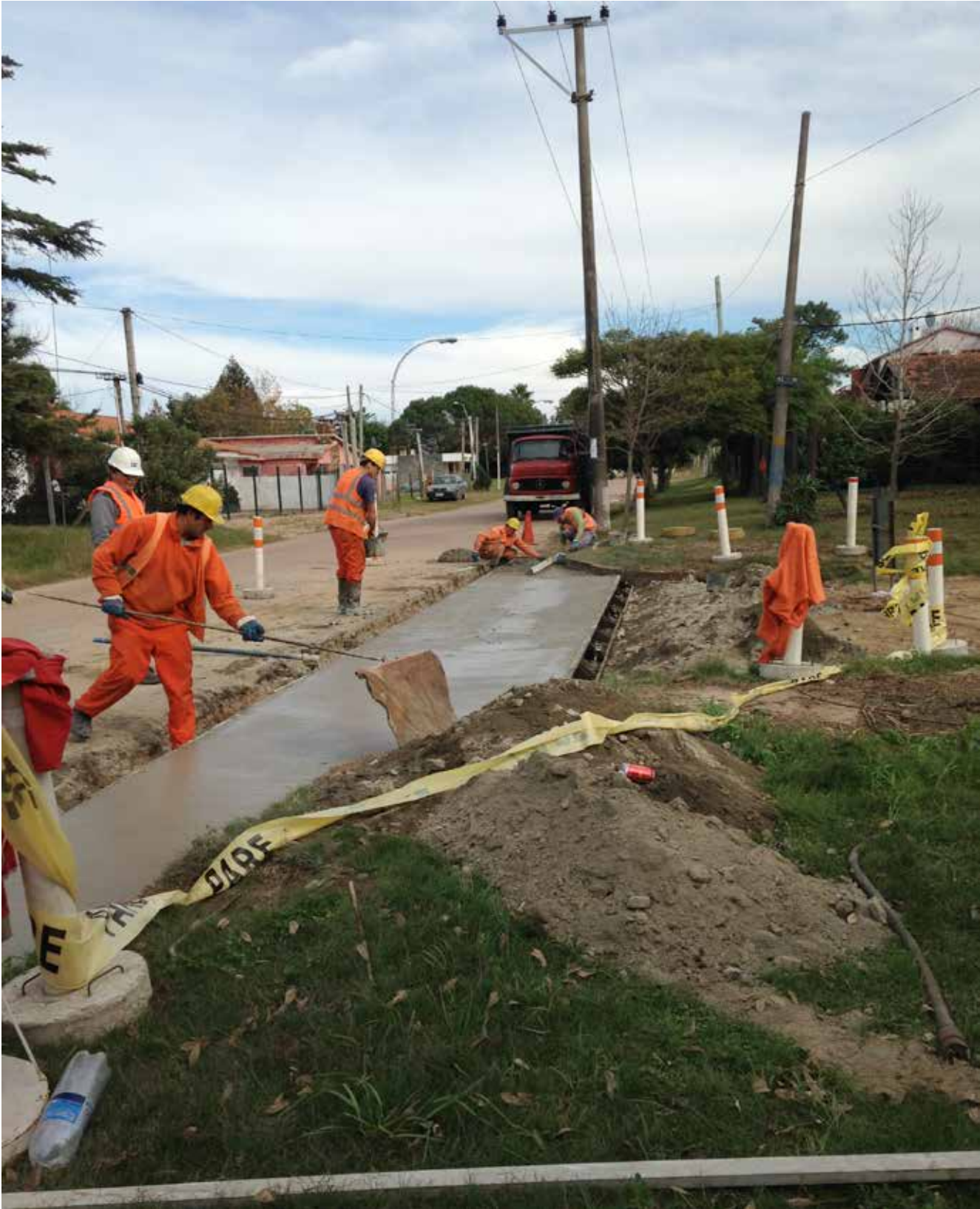
Ejecución de badén
