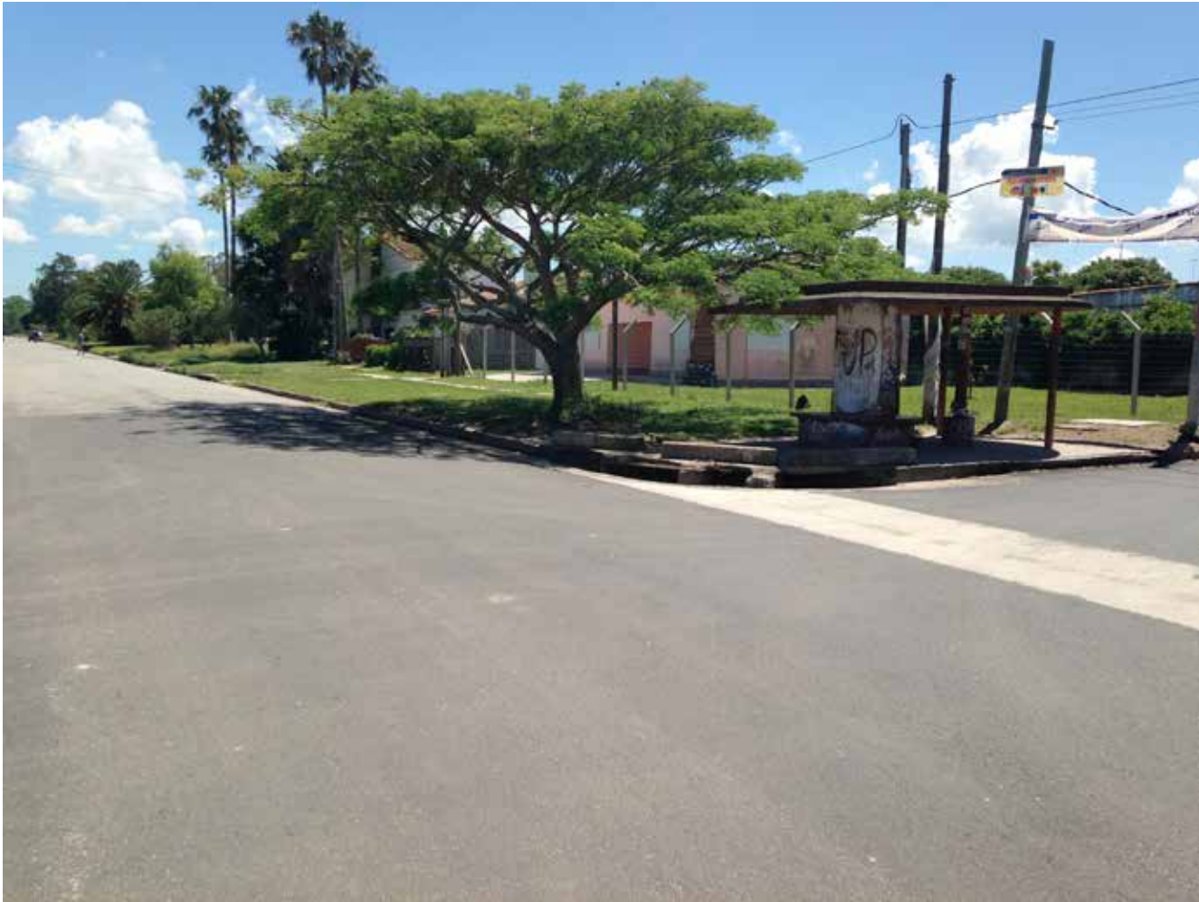
Pavimentos y badenes de hormigón finalizados
