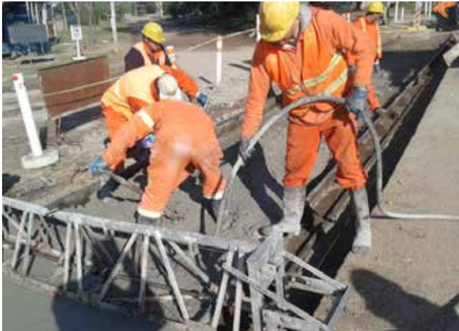
Ejecución de badén
