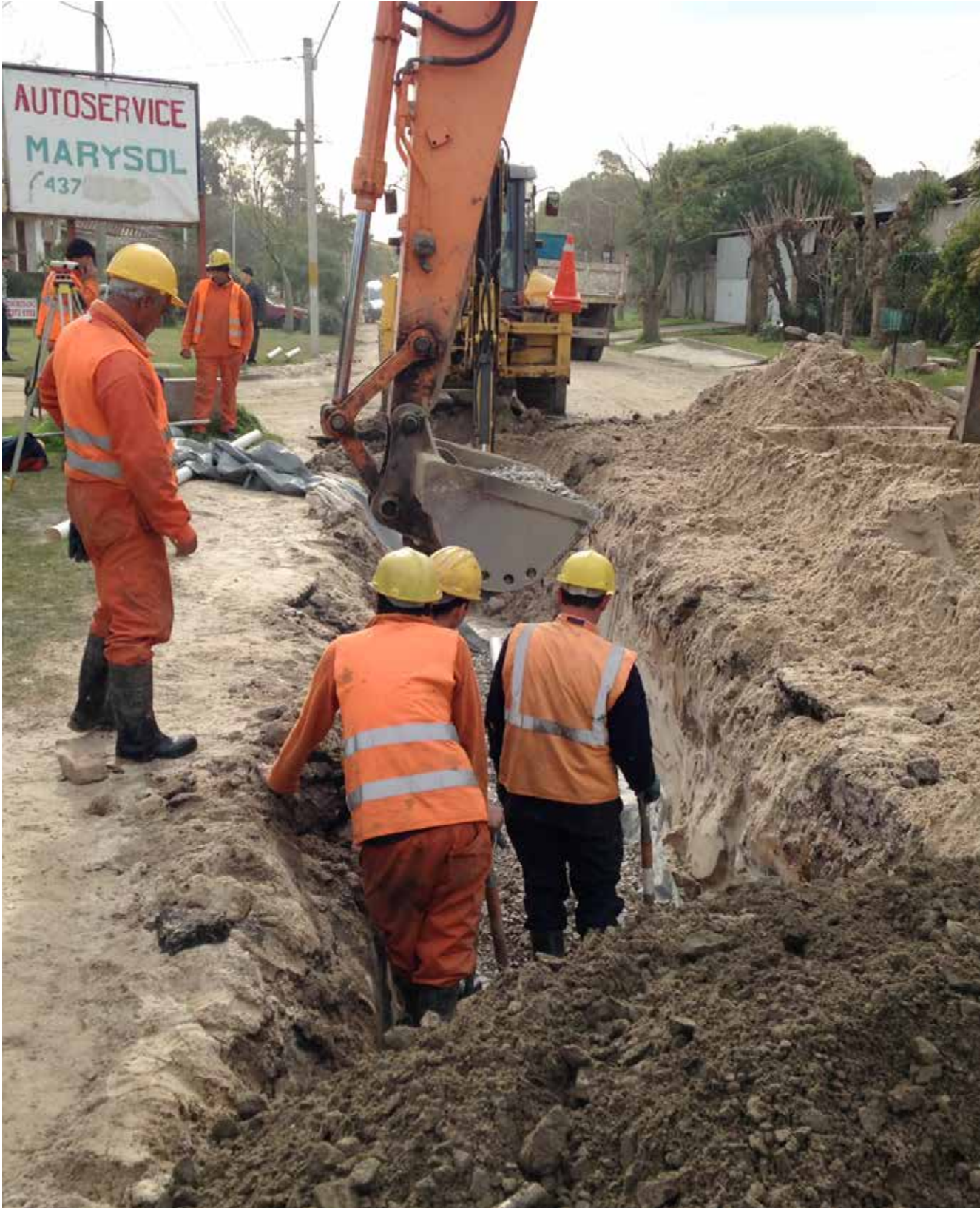
Ejecución de drenes Calle 1
