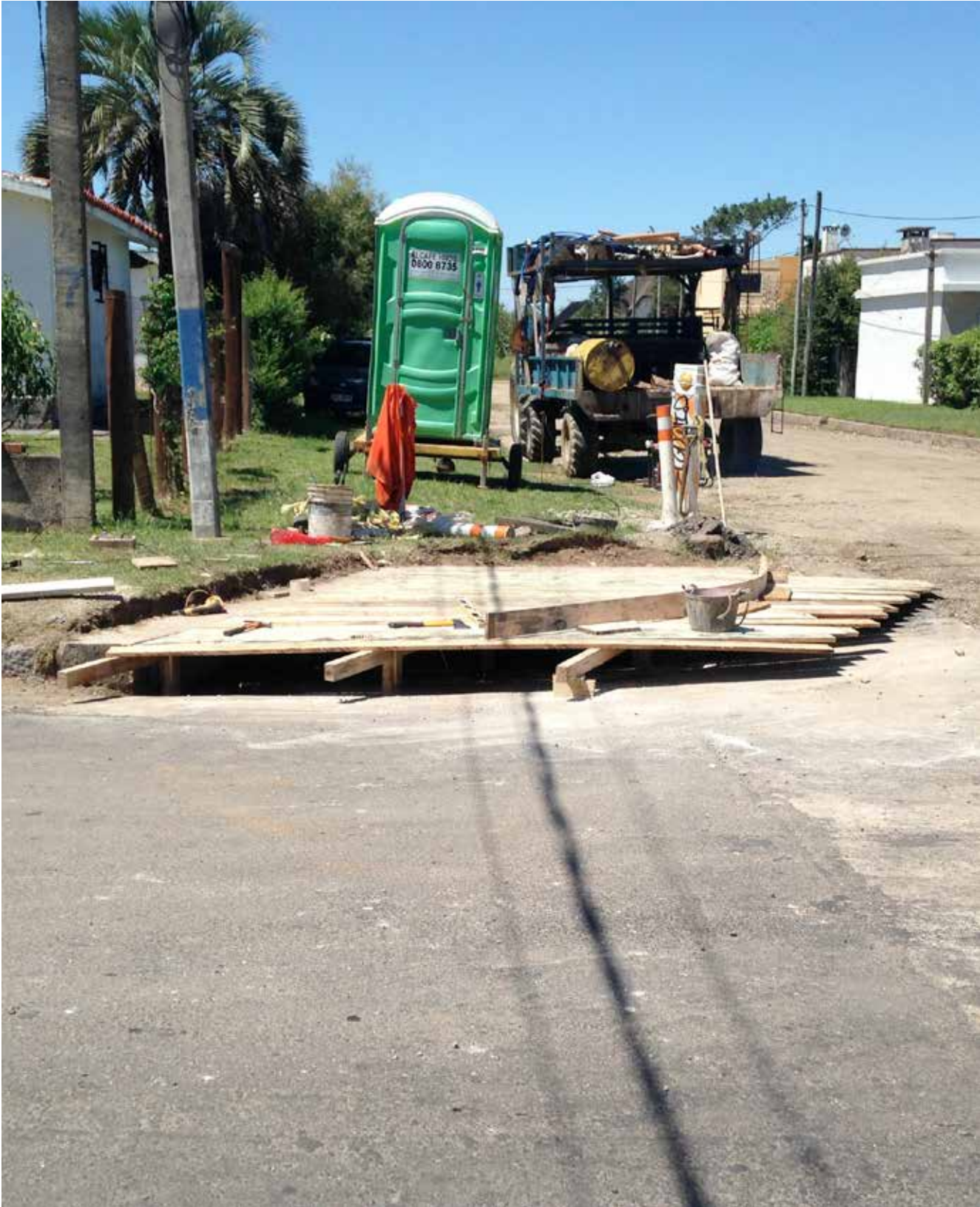
Reparación bocas de tormenta
