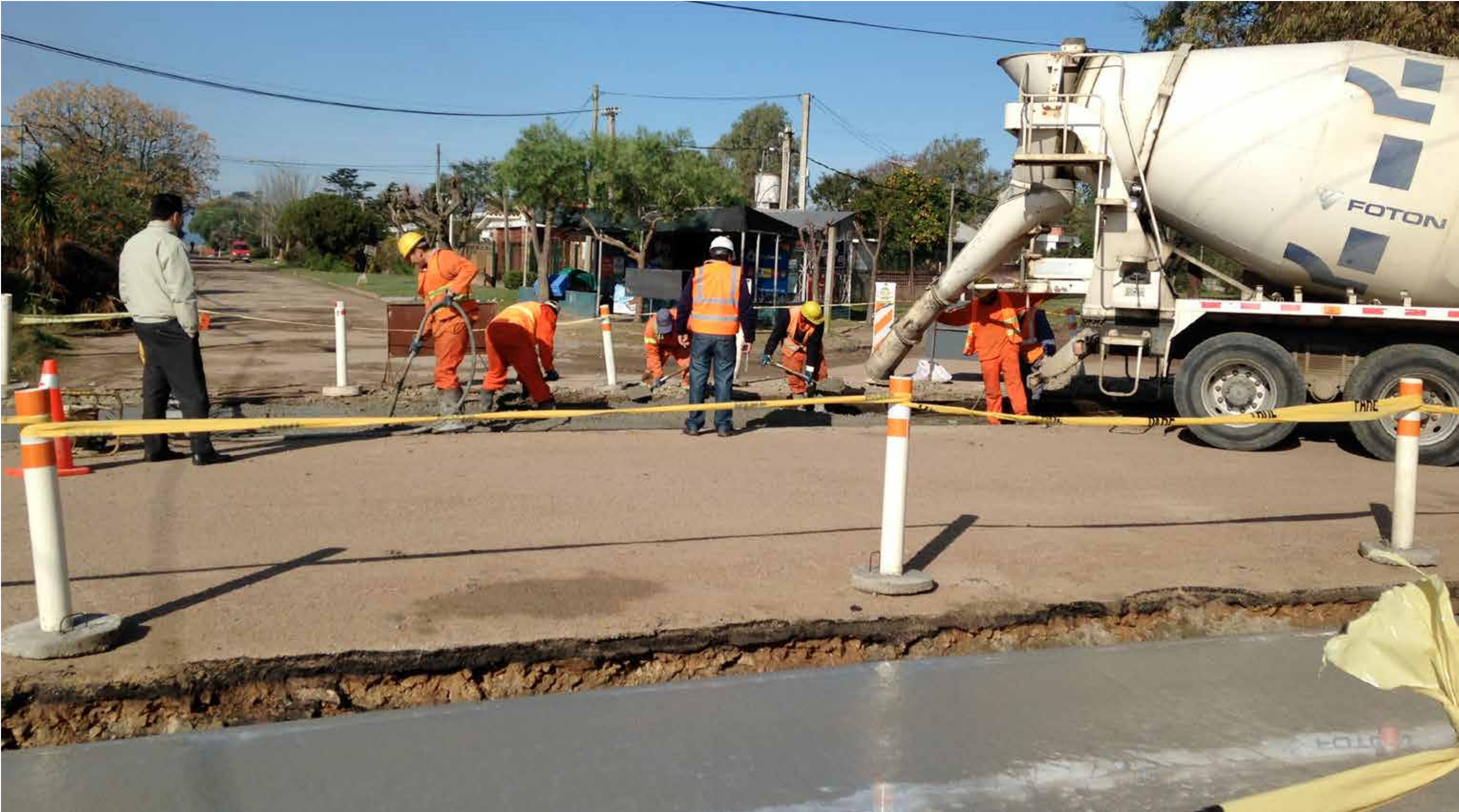
Ejecución de badén
