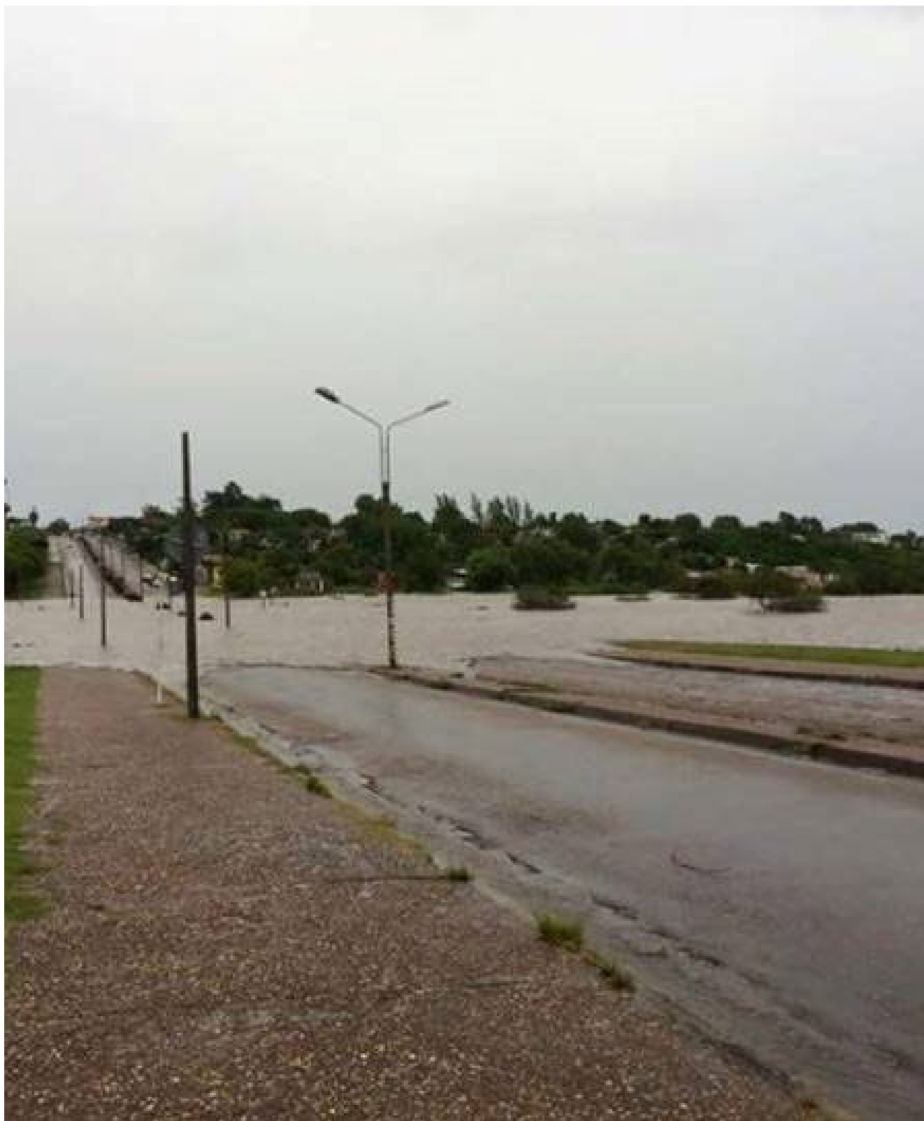
Avenida inundada en cruce con Zanja Caballero por crecida del Río Cuareim
