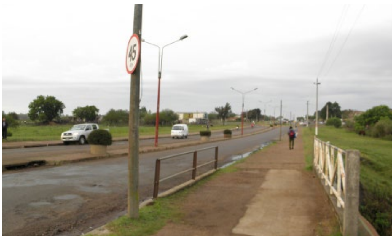
Situación antes de la intervención
