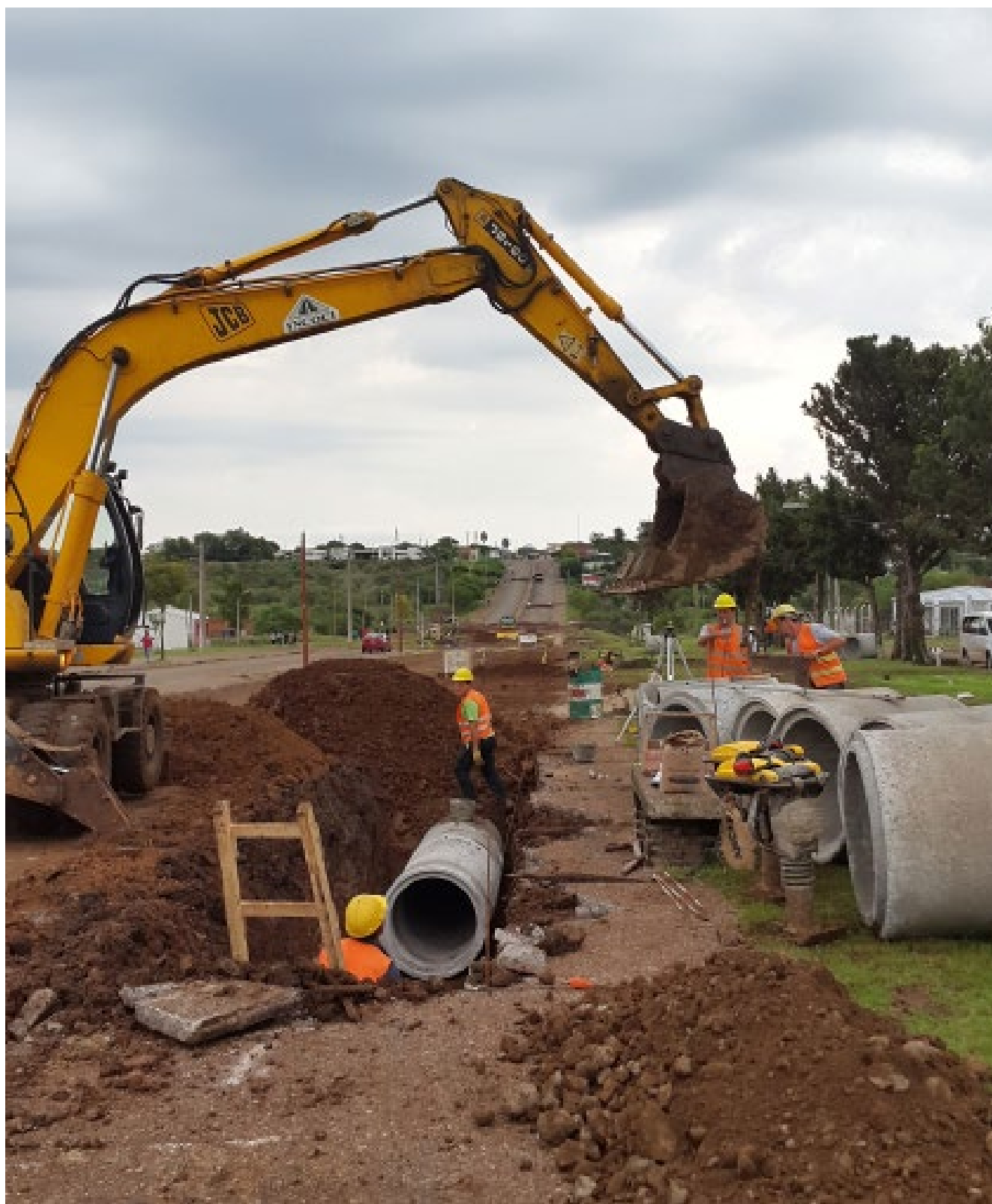
Tendido de tuberías para pluviales y construcción de bocas de tormenta
