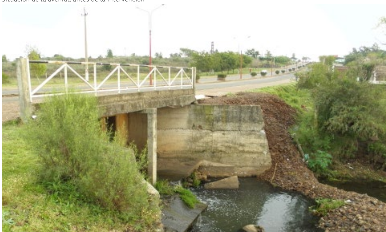
Alcantarilla existente antes de la intervención
