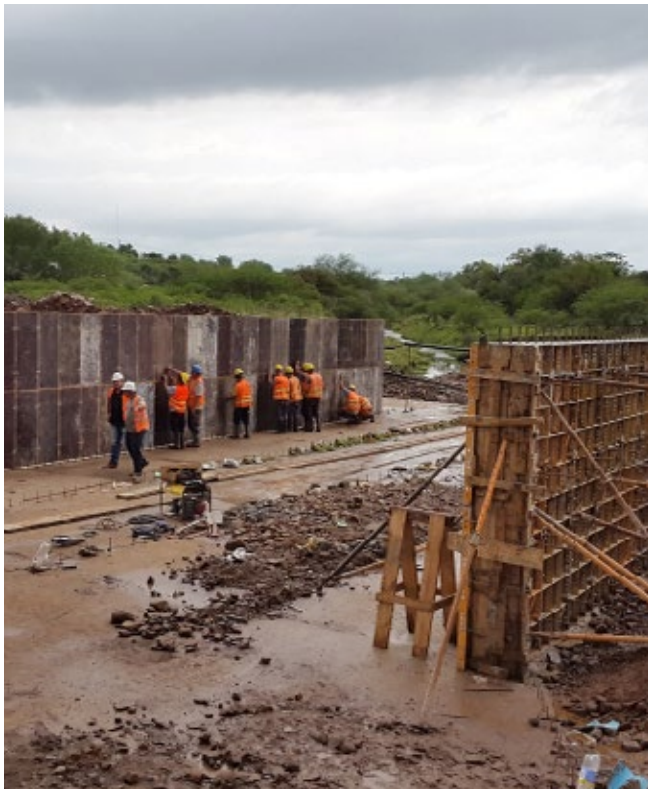
Proceso de construcción de la alcantarilla sobre la cañada Zanja Caballero
