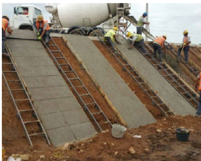
Construcción de protección de taludes en zonas aledañas a la alcantarilla sobre cañada Zanja Caballero
