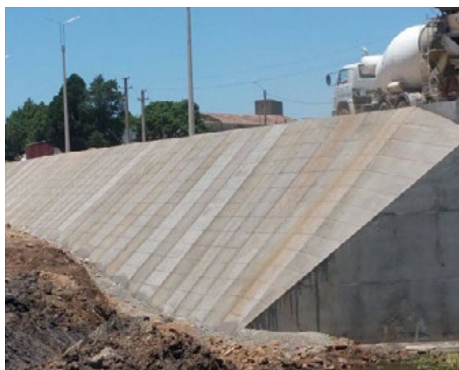
Construcción de protección de taludes en zonas aledañas a la alcantarilla sobre cañada Zanja Caballero
