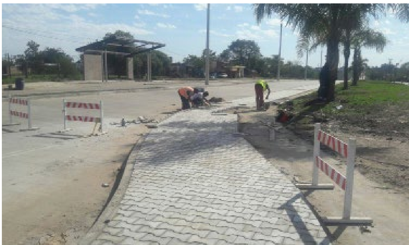
Trabajos por administración ejecutados por la Intendencia de Artigas como contrapartida departamental
