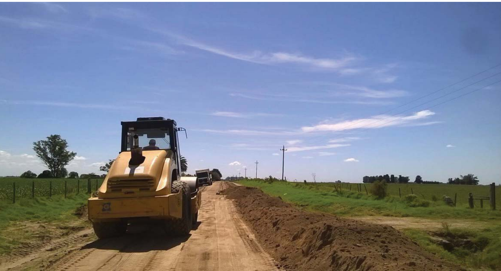
Obras de caminería rural en camino Duraznito (Soriano)
